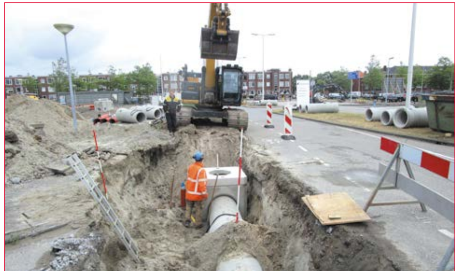
De afvoer moest steeds blijven functioneren.
